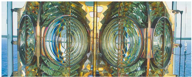
Die Fresnel-Linsen des Leuchtturms Roches-Douvres, dem mit 40 Kilometern am weitesten vom Festland entfernten Leuchtturm Frankreichs an der Bretagneküste
